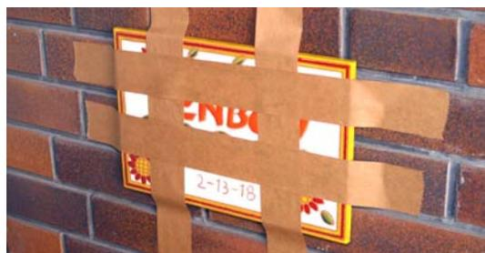
B) 強力なガムテープでタイルをしっかり固定します。1~2日、完全に接着剤が乾いたのを確認し、ガムテープを外してください。
