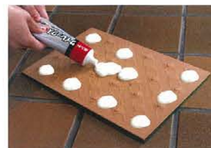
A) タイルの裏面に団子状にたっぷりと接着剤を塗布します。
